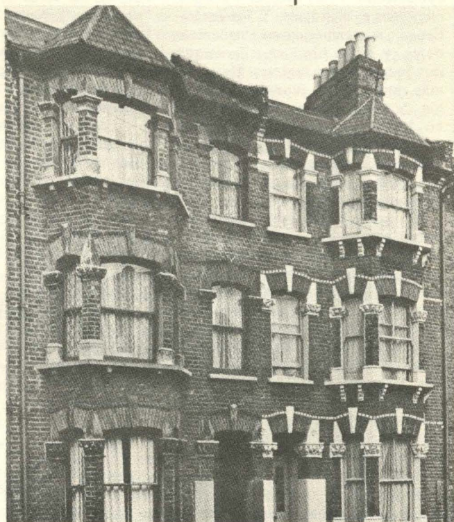
Modelo de casa victoriana ubicada al sur de Kensington.
